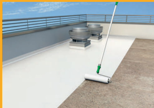
Impermeabilização de lajes expostas sem trânsito
