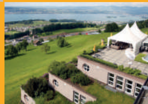
Impermeabilização de jardineiras e coberturas verdes
